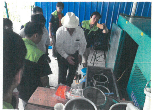
上海の協力会社内でのディーゼル発電機公開テストの様子。
